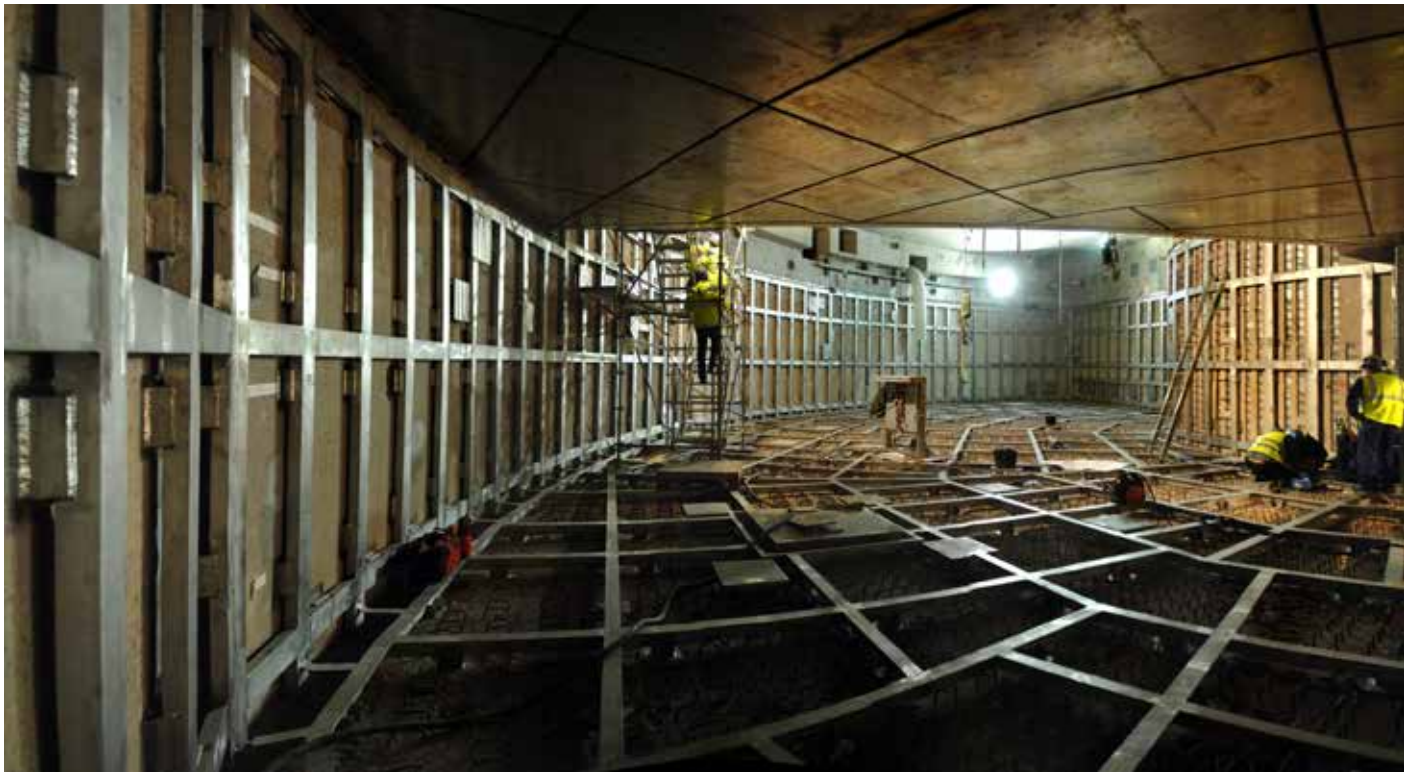
Olkiluoto 3: IRWST Liner
