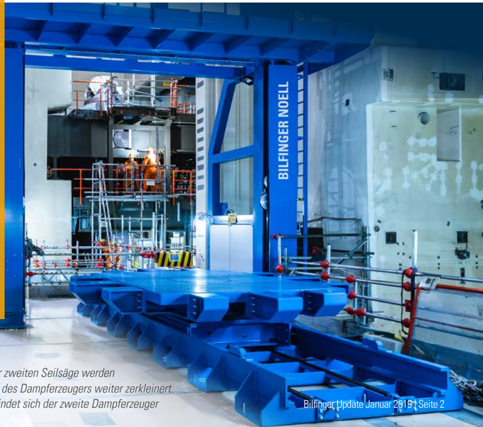
Stefan Brauer (Bilfinger Noell) testet die Bedienung einer Seilsäge
