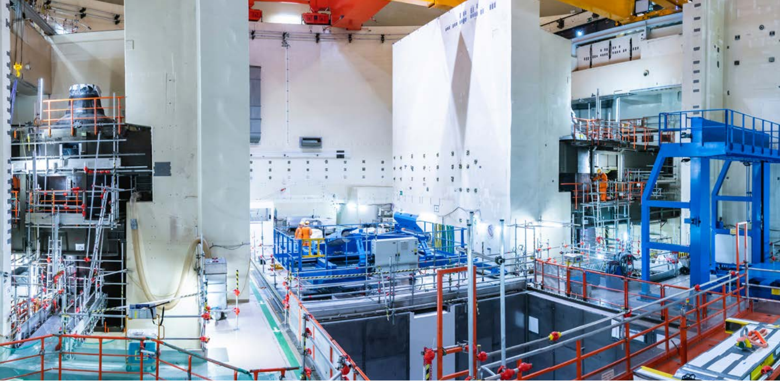
Blick in den Kontrollbereich des Kraftwerks. Die Seilsäge in der Mitte wird zur Zerteilung auf den ersten Dampferzeuger (links) montiert
